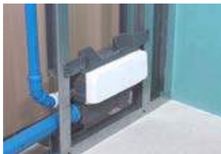
Aplicação em calha técnica
