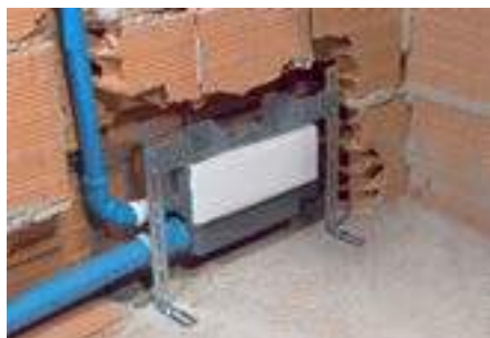
Aplicação em parede de alvenaria
