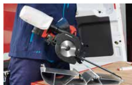
Corte de varilla
