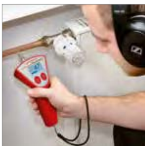
Detección de fugas en instalación de agua caliente
