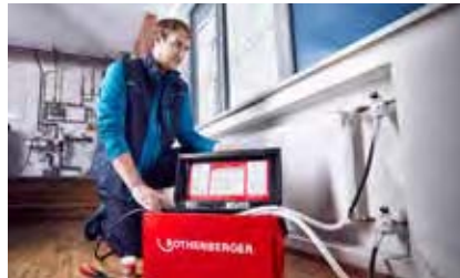
El proceso de congelación se inicia automáticamente después de instalar las pinzas de congelación
